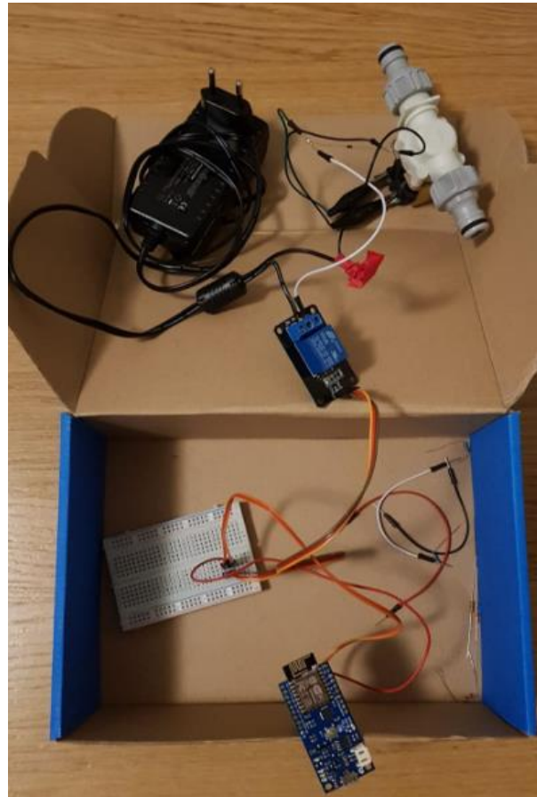
Slika 18. CROduino Nova sa spojenim elektromagnetnim ventilom
