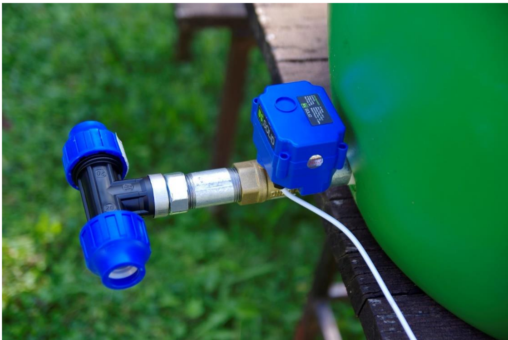
Slika 29 Prikaz ventila na modulu za navodnjavanje
