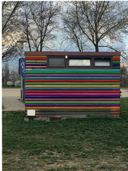
Sanitarni čvorovi s jedne strane obojani bojom za drvo.
