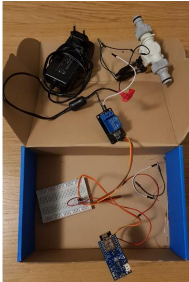
Slika 18. CROduino Nova sa spojenim elektromagnetnim ventilom
